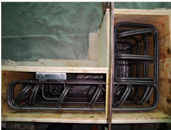
Figure 2.1: Avant le bétonnage de la partie “ mur ” : Coffrage, armatures et fers en attente de type CISA-30 avec languette en plastique intégrée.
