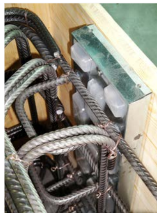
Figure 2.1: Avant le bétonnage de la partie “ mur ” : Coffrage, armatures et fers en attente de type CISA-30 avec languette en plastique intégrée.
