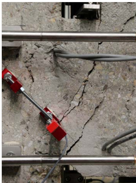
Figure 4.2: Mode de rupture du Spécimen 2
